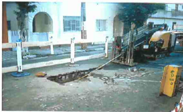
Figura 4.2 – Perfuratriz ou Máquina de Furo em operação Fonte: Massara (2007)
